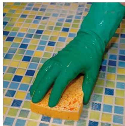
Zmywanie mozaiki zaspoinowanej PCI Durapox® NT plus.
