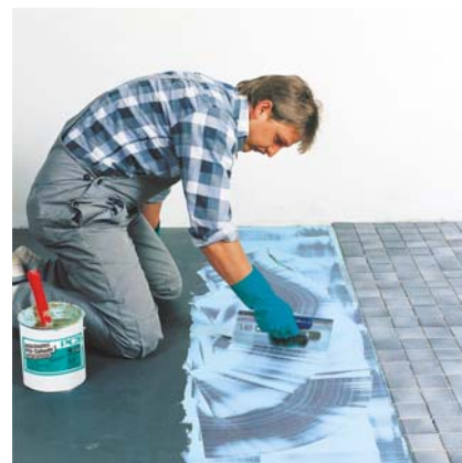
Płytki układa się na nałożonej grzebieniem warstwie kleju i wyrównuje.
