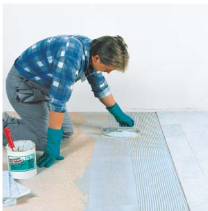
PCI Collastic® nadaje się do wyklejania płytek na podłożach wrażliwych na wilgoć, np. płytach wiórowych.
