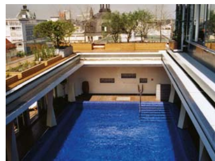
Okładzina płytkowa w nieszcepowym wyklejona na PCI Collastic®.
