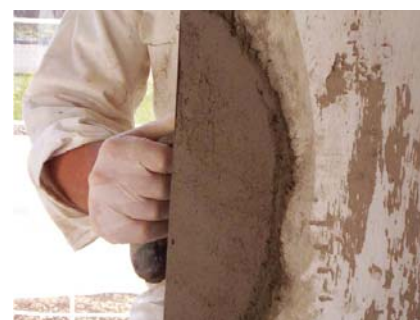
Naprawa naroży to tylko jedna z możliwości zastosowania wszechstronnej zaprawy PCI Nanocret® R2.
