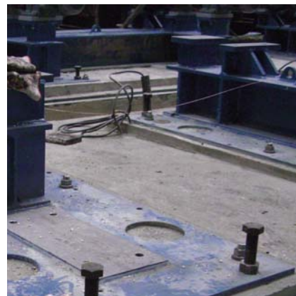
PCI Repaflow® nadaje się do podlewki precyzyjnych, co pozytywnie wpływa na żywotność maszyn.
