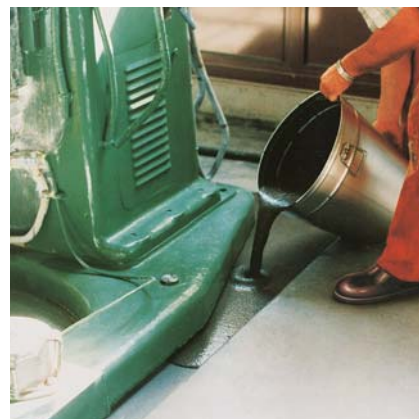
PCI Repaflow® posiada wysoką rozplywność i samoczynnie wypełnia także poziome przestrzenie.
