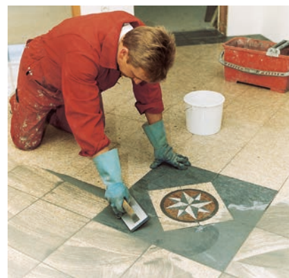
PCI FT® Megafug pozwala na spoinowanie płytek gresowych w zakresie szerokości od 1 do 10 mm.
