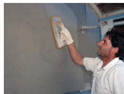
PCI Nanocret® FC – szpachłówka do napraw betonu w zakresie grubości warstwy od 1 do 10 mm.
