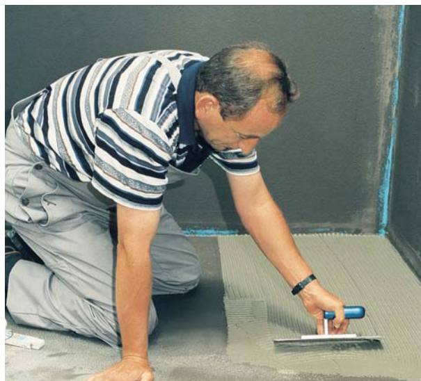
Kleje do płytek modyfikowane PCI Lastoflex redukują naprężenia podłoża i kompensują naprężenia powodowane przez różnice temperatur.
