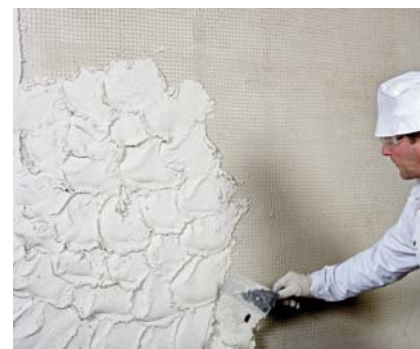
Nakładanie drugiej warstwy zaprawy na „przeczesanej” pierwszej warstwie PCI Saniment® 02.
