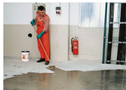
Impregnowanie jastrychu cementowego
