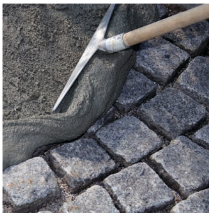
W metodzie szlamowania PCI Pavifix® CEM można łatwo wprowadzić w spoiny za pomocą rakli gumowej
