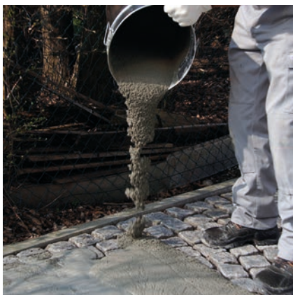
Aplikacja PCI Pavifix® CEM na powierzchnię przeznaczoną do spoinowania.
