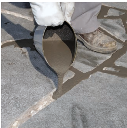
Odpowiednim naczyniem do zalewania wprowadzić PCI Pavifix® CEM w przygotowane spoiny.
