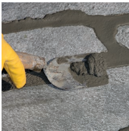
Usunąć nadmiar materiału kielnią.
