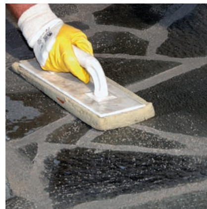
W ciągu godziny zmyć okładzinę płytkową packą z gąbką.
