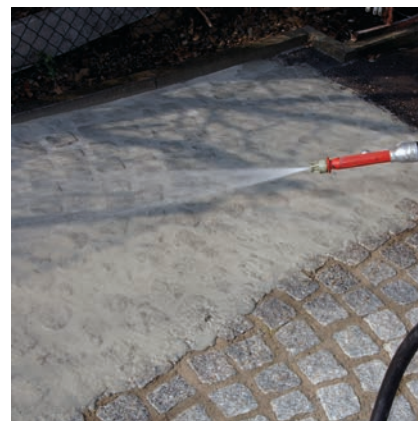
W celu uniknięcia wypłukiwania spoin podczas czyszczenia kostki brukowej należy trzymać strumień wody niemal równoległe do powierzchni.
