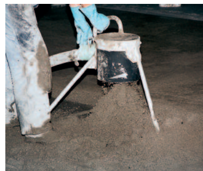
Szybkosprawny jastrych na spoiwie PCI Novoment® Z3 charakteryzuje się długim czasem użycia, również w wysokich temperaturach oraz możliwością podawania pompą.
